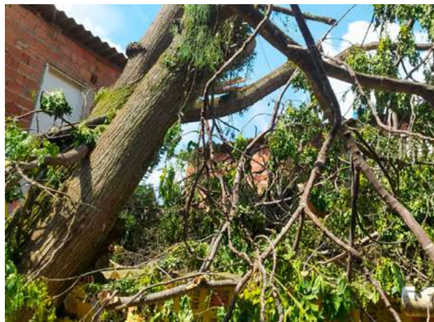
Árvore que caiu na casa de Rosa Maria Gonçalves, em Jandira
